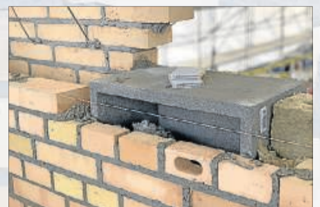
24 redekasser og specialfremstillede mursten med flyvehuller tilpasset mursejlerne blev indsat i de renoverede gavle på Dalhusene. (Fotos: Arkitektfirma Hune & Elkjær)
